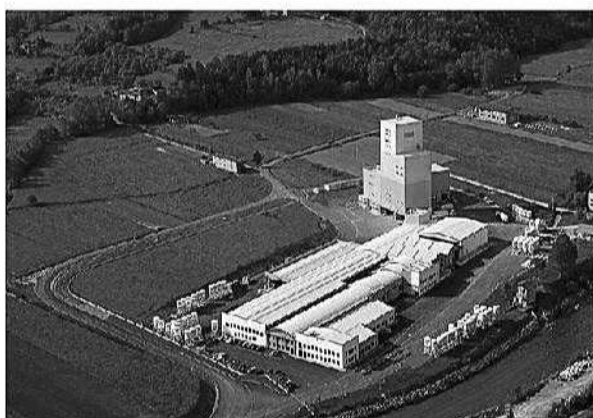
Stabilimento di Bagnasco (CN)
