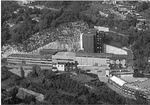
Stabilimento di Sala al Barro (LC)
