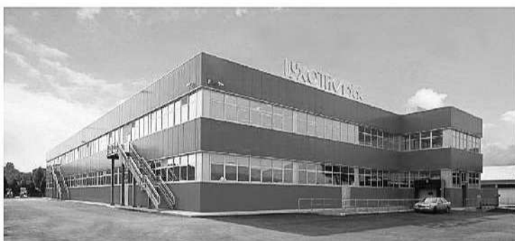
Stabilimento di Pederobba
